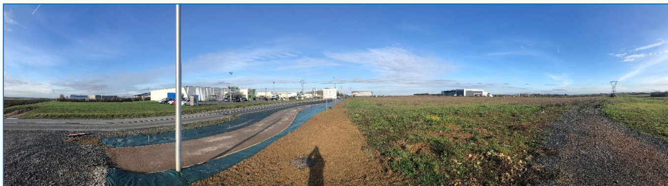
Vue actuelle depuis le haut de la ZAC du grand clos vers les nouvelles constructions de la ZA – Source : Quarante Deux
