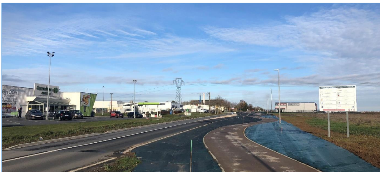
Figure 54 : Aménagement réalisé sur la RD23 au droit de la zone d'activités
