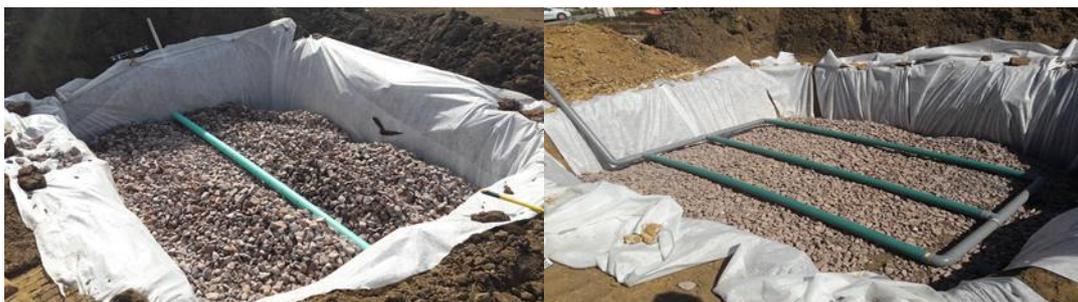
Les matériaux utilisés pour la zone d'infiltration pourront être soit des matériaux issus de carrières tels que des gravas drainantes 20/60 avec un indice de vide de 30%, soit des structures alvéolaires (structures synthétiques possédant un indice de vide de l'ordre de 90%).
