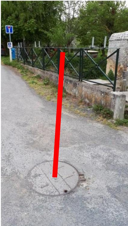
Remplacement et approfondissement du regard avec chute guidée du tronçon amont
