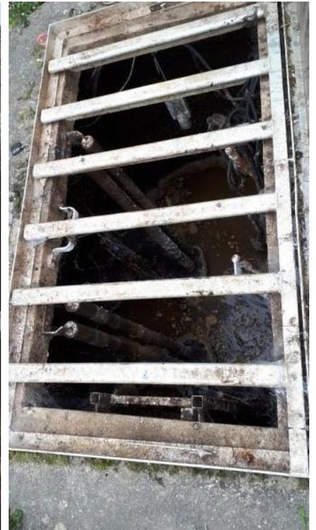
Dépose des équipements, nettoyage et comblement des regards (dépose des trappes)
